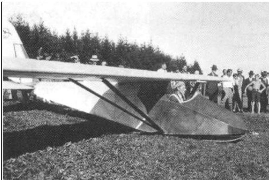
*„Bereits 1925 hatte ich mit der Konstruktion und den Berechnungen für ein leistungsfähiges Segelflugzeug, einen Eindecker mit 12,5 m Spannweite begonnen. Der Raum in unserer Wohnung, die wir damals bewohnten, war relativ klein, weshalb der Rumpf der S 9 in zwei Teile gebaut und nachher zusammengeschaftet werden musste ...“ (Spalinger: „Fliegen wie ein Milan“)*
