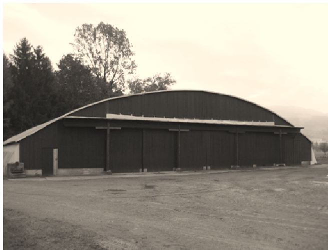
Hangar (von dreien steht nur noch einer)
